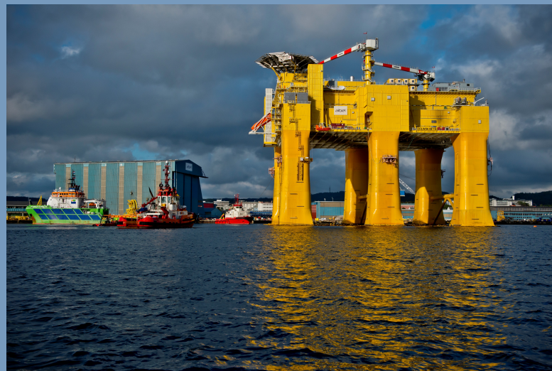
Foto: Øyvind Sætre/Aibel
